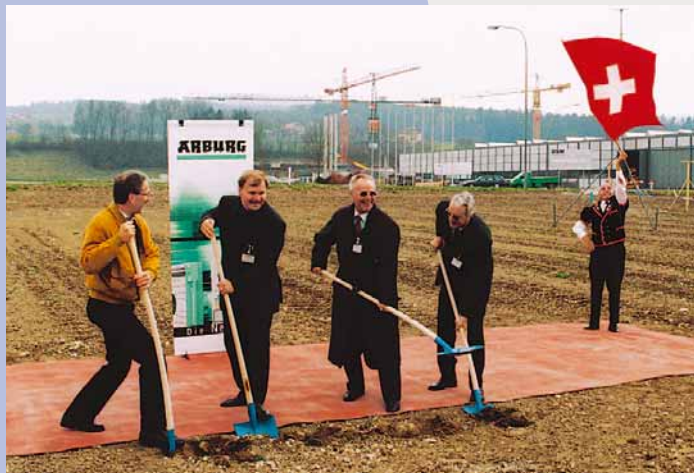
Excavaciones llenas de brío: Eugen Hehl (2º por la derecha), el Jefe de la filial, Peter Moser (derecha), el constructor de ARBURG, Manfred Wolfer (2º por la izquierda) y el arquitecto Jörg Jost (izquierda), dan con ímpetu la primera palada en el suizo terreno de Münsingen.
